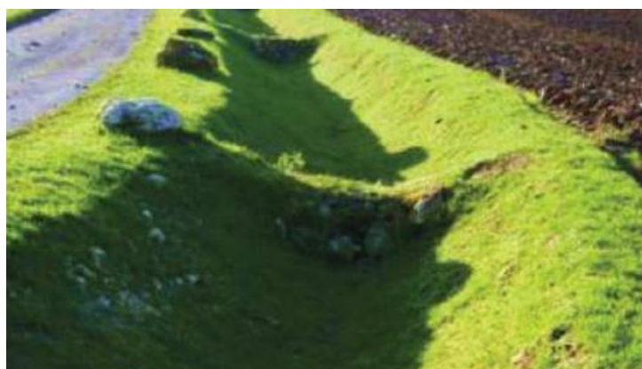
Figure 41 : Illustration d'un fossé à redent (Source : www.giser.be )
