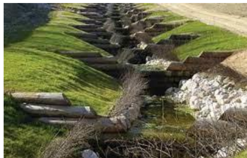
Photo 5 - Fossé aménagé avec ressauts pour correction torrentielle
