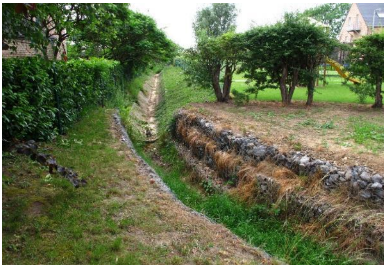
Photo 1 - fossé trapézoïdal en béton suivi d'un fossé renforcé en gabions
