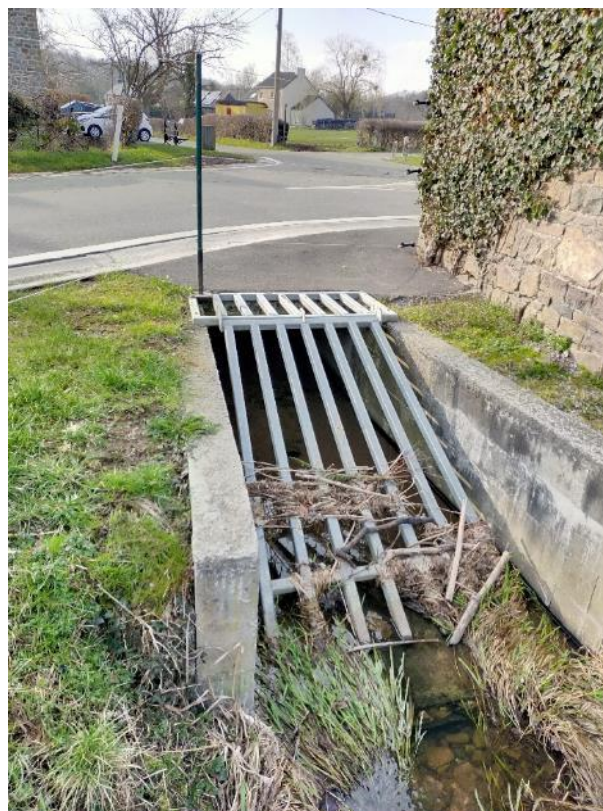
Photo 4 et 5 - Exutoire du fossé protégé par un voile béton et muni d'une grille anti-embâcles inclinée (idéal)
