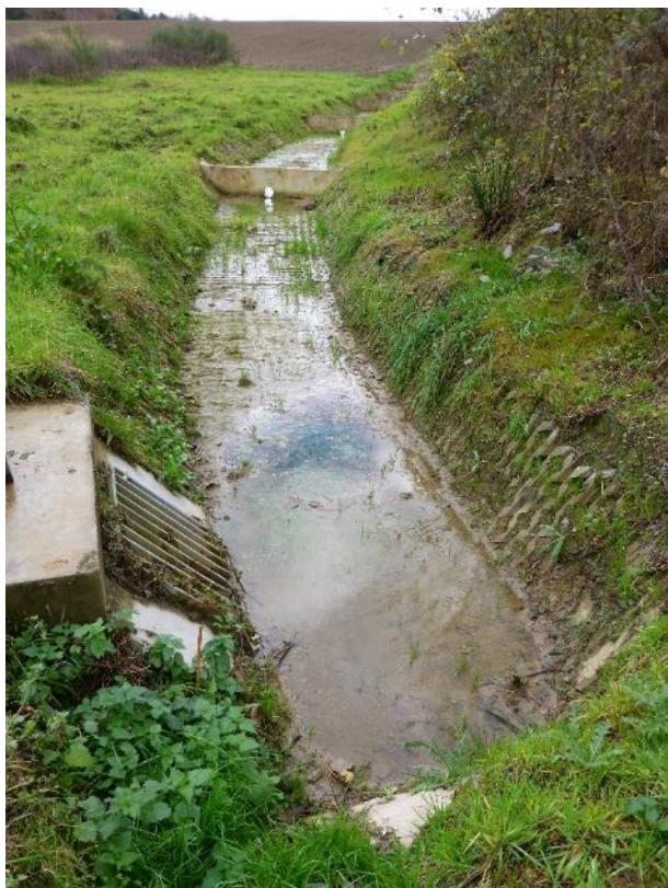
Photo 4 et 5 - Exutoire du fossé protégé par un voile béton et muni d'une grille anti-embâcles inclinée (idéal)
