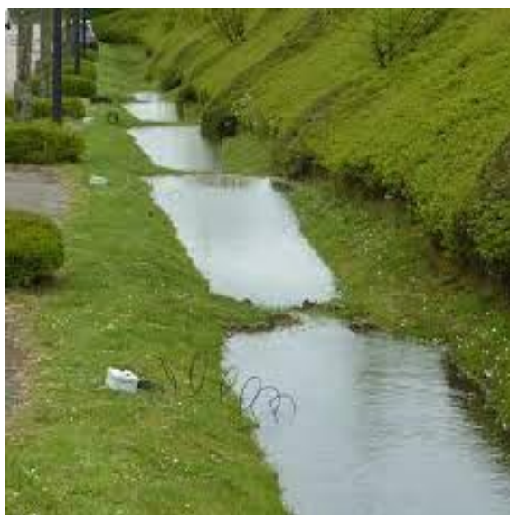
Fossé à redents en fonctionnement
