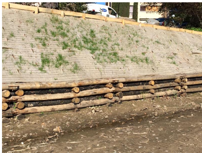
Caissons végétalisés (bas du talus) et protection géotextile (haut du talus)
